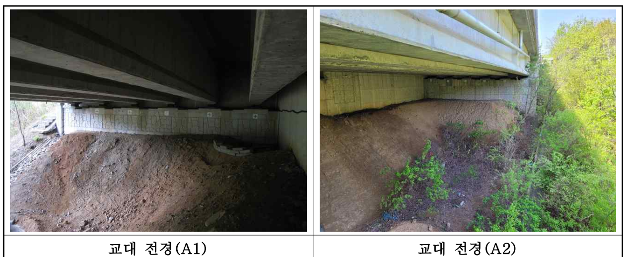
【사진 3.3.8】 교대 전경
