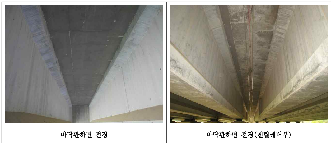
【사진 3.3.2】 바닥판하면 전경
