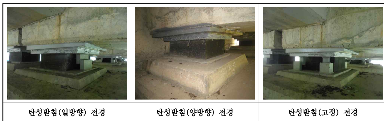
【사진 3.3.12】 교량받침 전경
