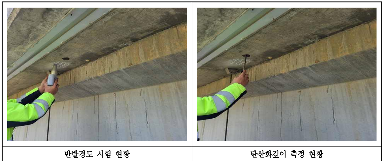
【사진 3.4.1】 콘크리트 내구성조사 현황
