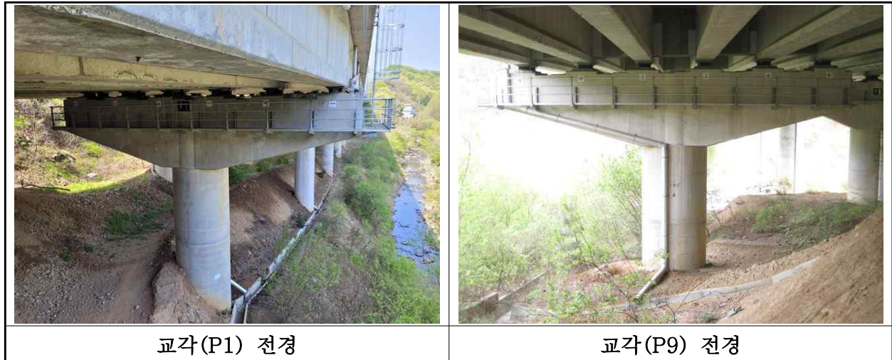
【사진 3.3.10】 교각 전경
