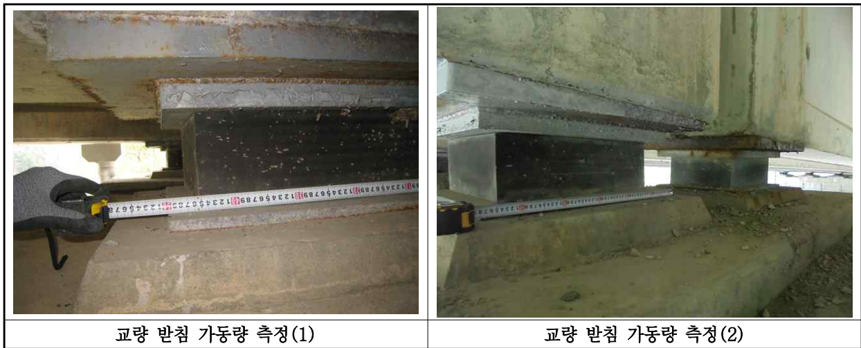
【사진 3.3.15】 교량받침 이동량 측정
