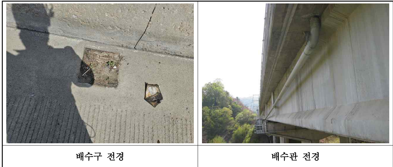
【사진 3.3.21】 배수시설 전경
