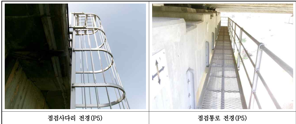
【사진 3.3.25】 교량 점검시설 전경
