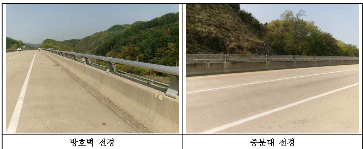
【사진 3.3.23】 방호벽 및 중앙분리대 전경
